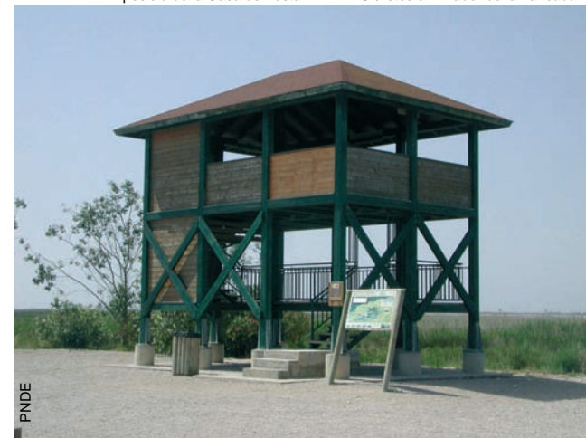
Mirador de la Casa de Fusta
