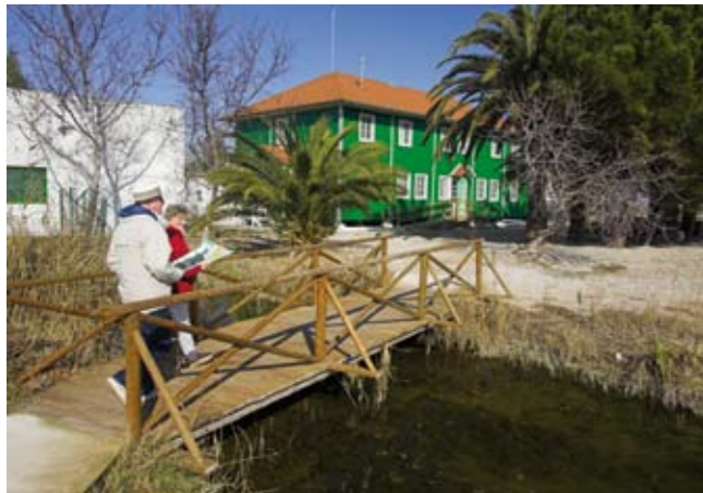
8 Casa de Fusta
