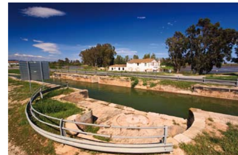
9 La Esclusa - Canal de Navegación
