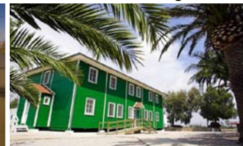
6 Casa de Fusta
