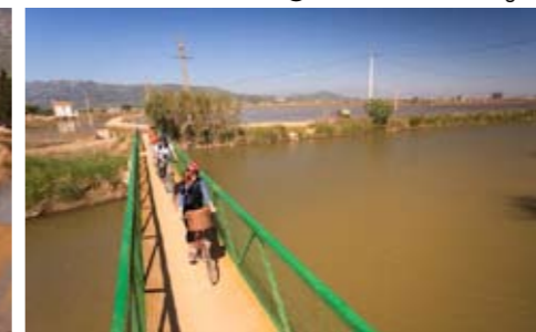
5 Pont dels Tres desaigües
